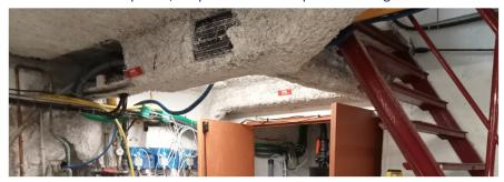
Reprise des supports de l'ensembles des luminaires et BAES du local technique lors de la réalisation du flocage coupefeu.
