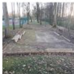
Remise en état du troisième terrain de boules Réalisation en interne. Réfection des pourtours. Retrait de la mousse et recharge en sable sur l'ensemble de la surface.
