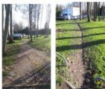
Réfection des allées de l'école. Réalisation en partie bétonnée.
